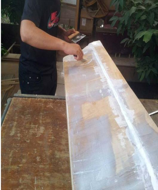
圖7.9 易進水的縫隙塗上補土
